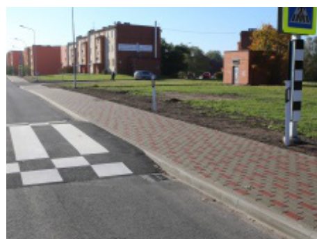
Remontdarbi Nākotnes ielā veiksmīgi noslēgušies.
