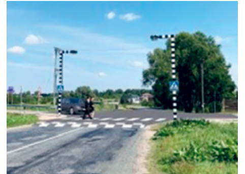
Pabeigti darbi izcelta krustojuma izbūvei Katlakalnā.
