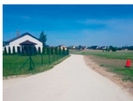
Pabeigti ūdensvada un kanalizācijas tīklu būvdarbi Loreķu laukā .
