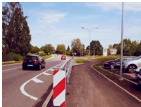
Ķekavā, Odukalnā, ir pabeigta gājēju ietve un apgaismojuma izbūve gar autoceļu A7.
