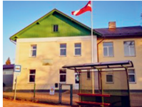
Izbūvēta pieturvietas nojume pie Pļavniekkalna sākumskolas.
